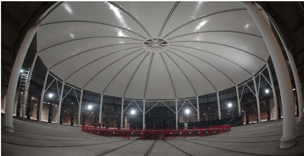
Casa de Máquinas - Museo Nacional Ferroviario de Temuco
