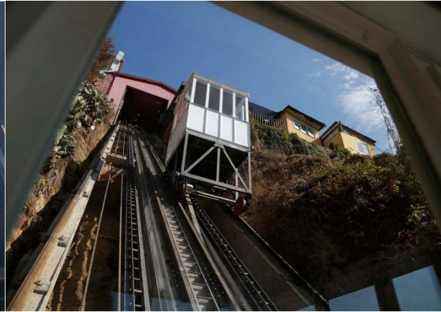
Restauración Ascensor Espíritu Santo Valparaíso.
